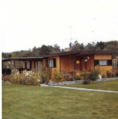
Huset efter beklædning med træ. Privatfoto.
